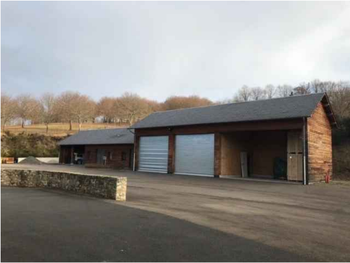
7.6 Vue sur les Ateliers
