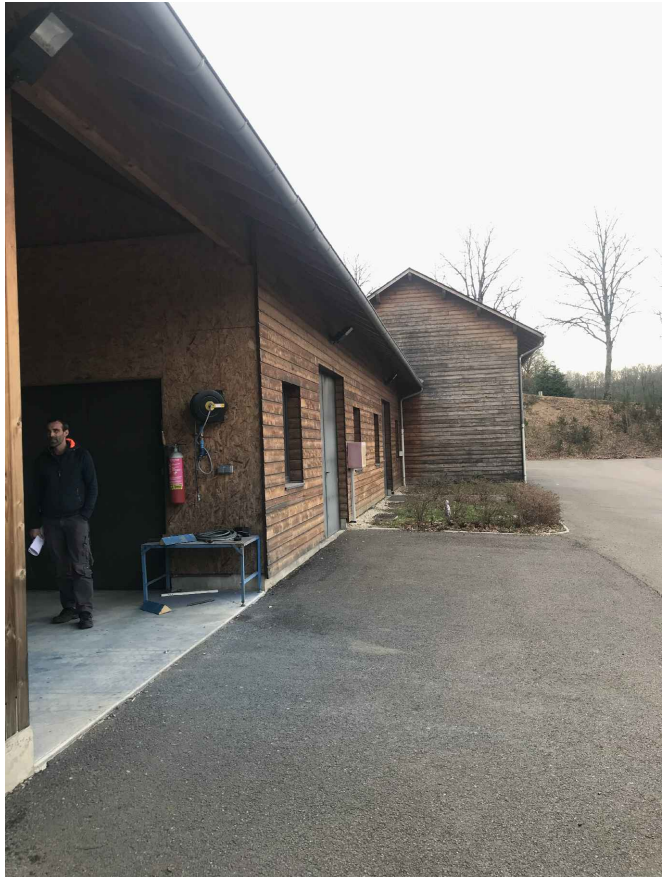
7.7 Vue sur les Ateliers
