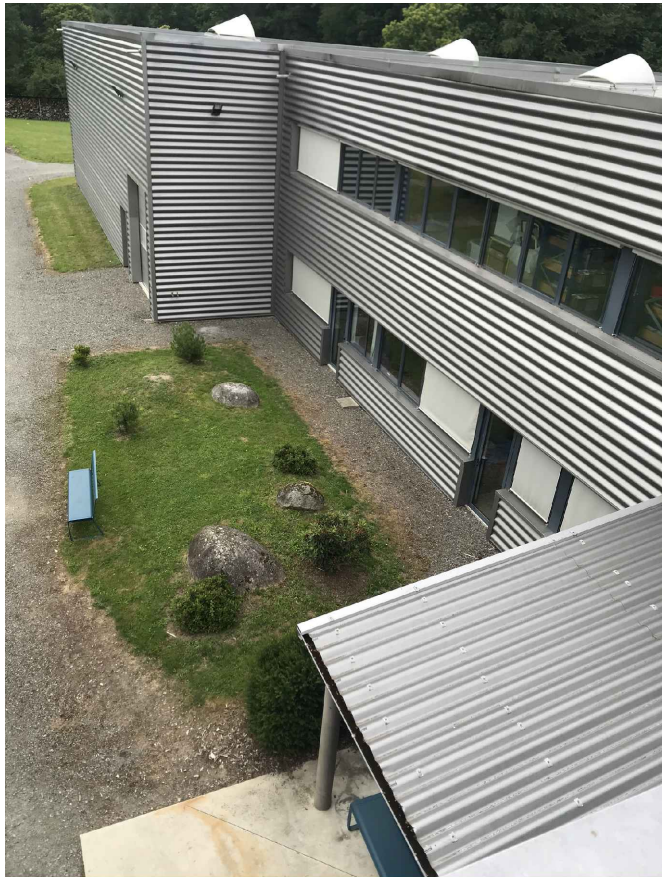
7.5 Vue sur les façades Sud Ouest
