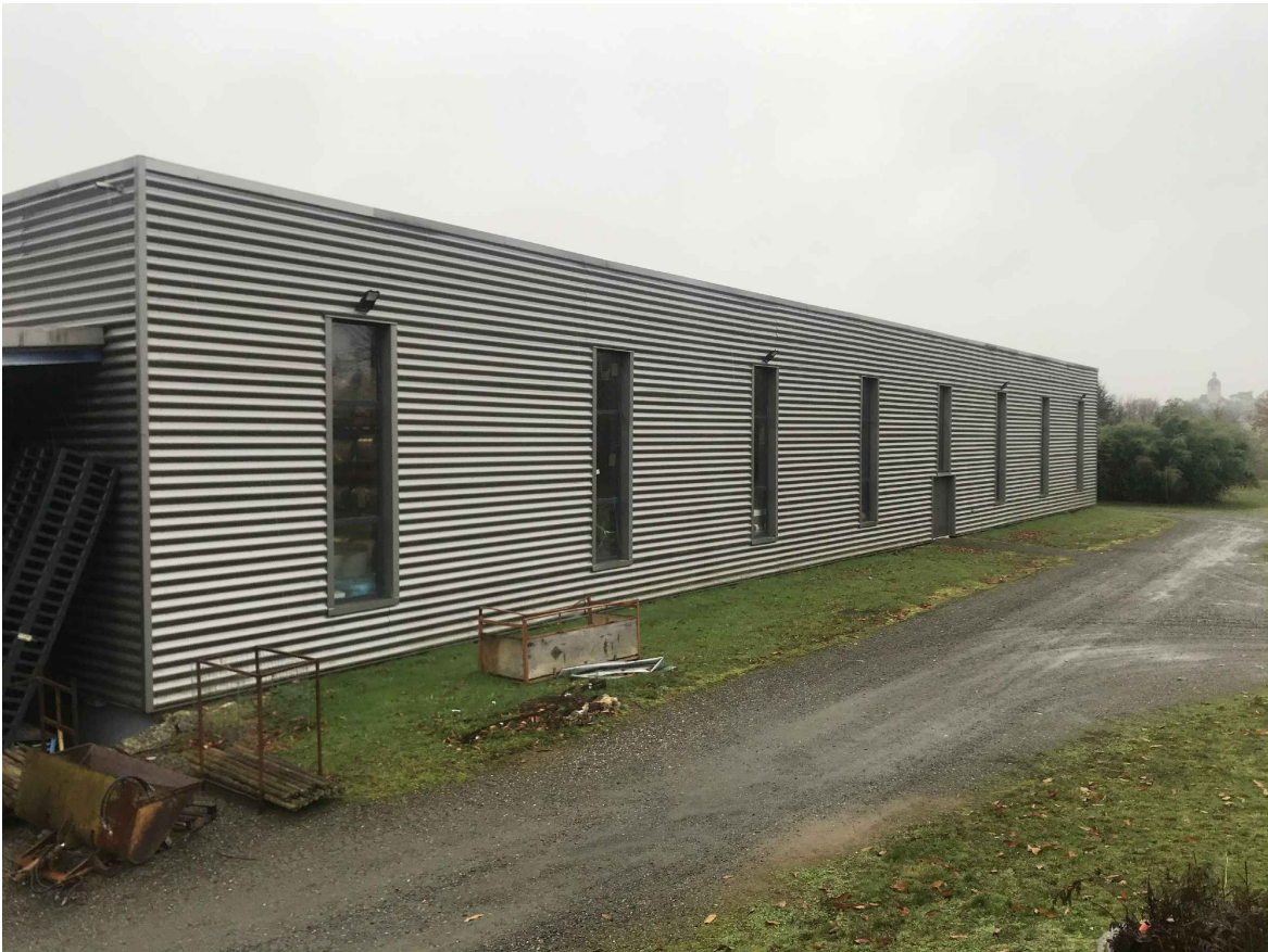
7.4 Vue sur la façade Nord Ouest de l'usine
