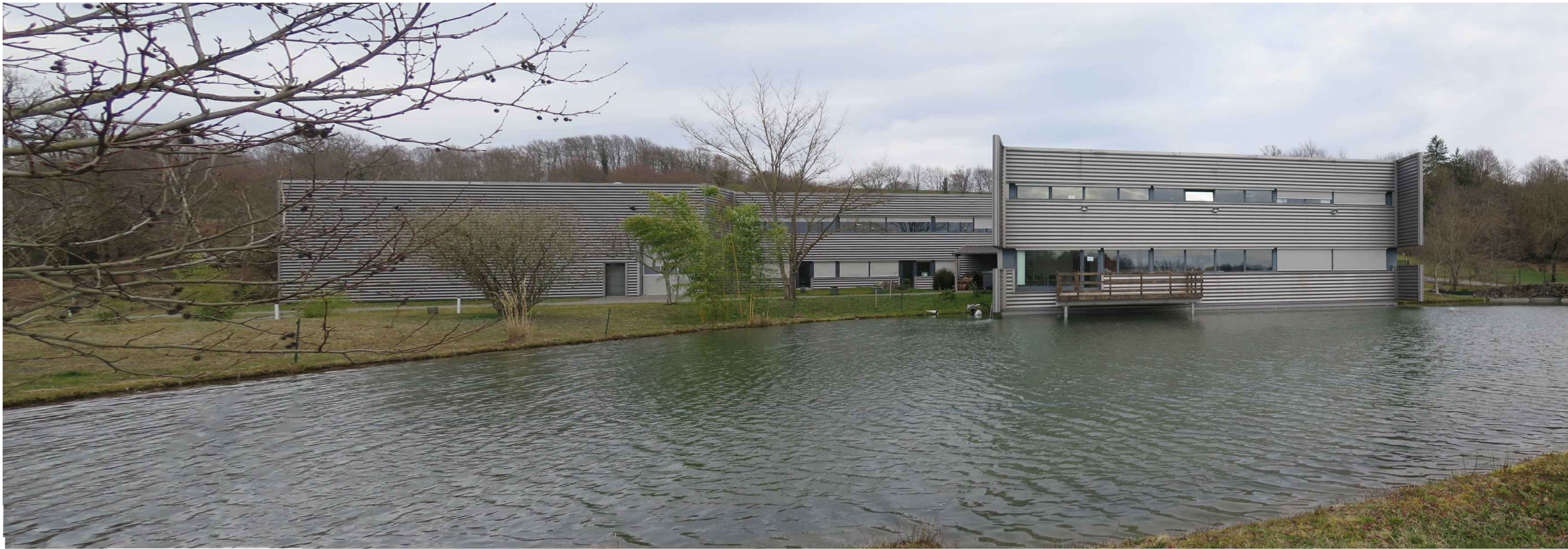
7.3 Vue depuis le Bassin vers l'usine existante
