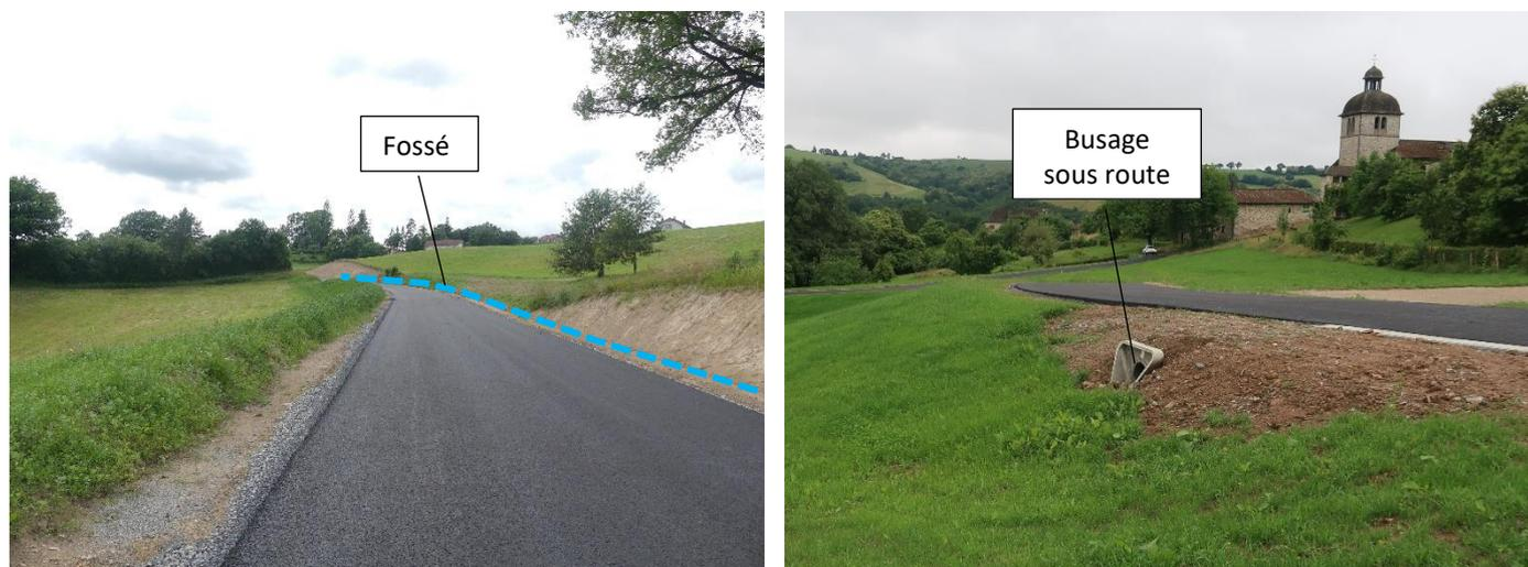
*Ouvrages hydrauliques de la nouvelle voie communale*
